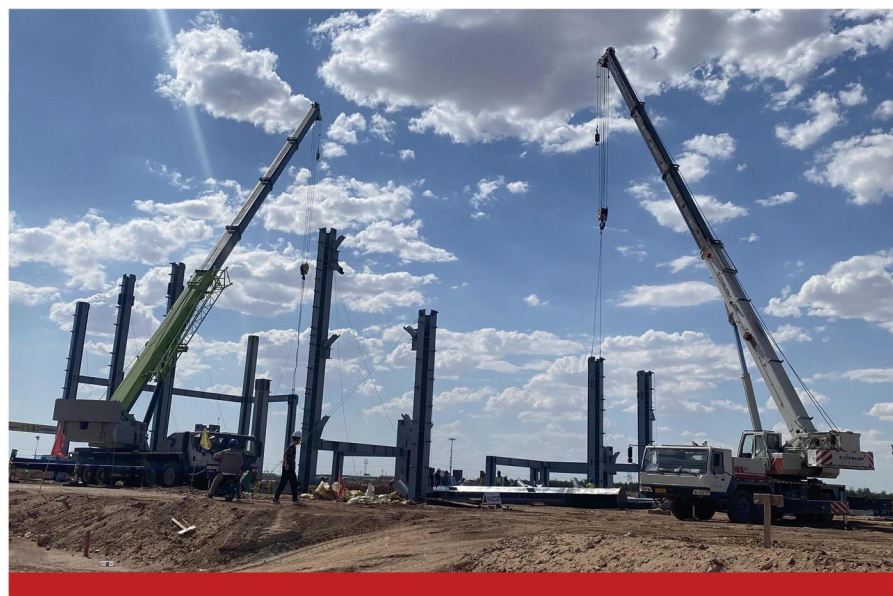
施工现场 / Visão do campo
